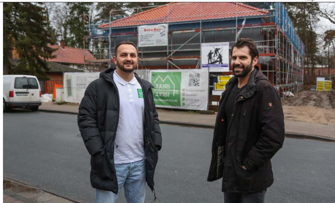
Einzugsbereit ab dem 1. Mai: Die Cousins Avni (links) und Jusuf Tairi haben mit Tairi & Tairi Projektbau eine Firma gegründet. Ihr erstes Projekt – am Gifhorner Lehmweg 16 – steht kurz vor der Fertigstellung. Foto: Çağla Canıdar
